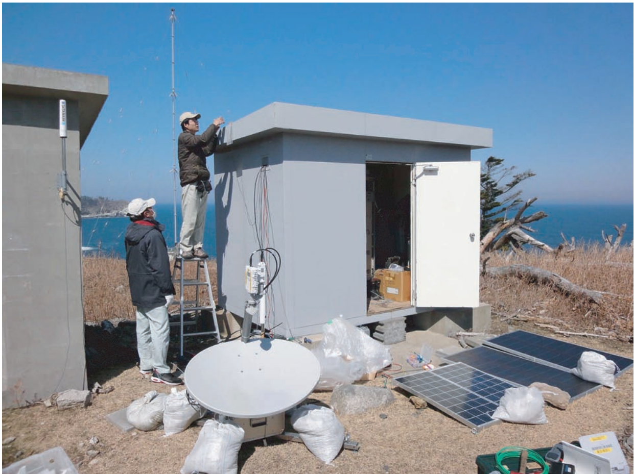
写真 宮城県に設置されている東北大学金華山観測点での復旧作業の様子（2011年4月1日撮影）。停電および電話回線不通のため、太陽電池パネルによる通信衛星テレメーター設備を設置して地震計、歪計、GPSのデータ伝送を復活させた。
