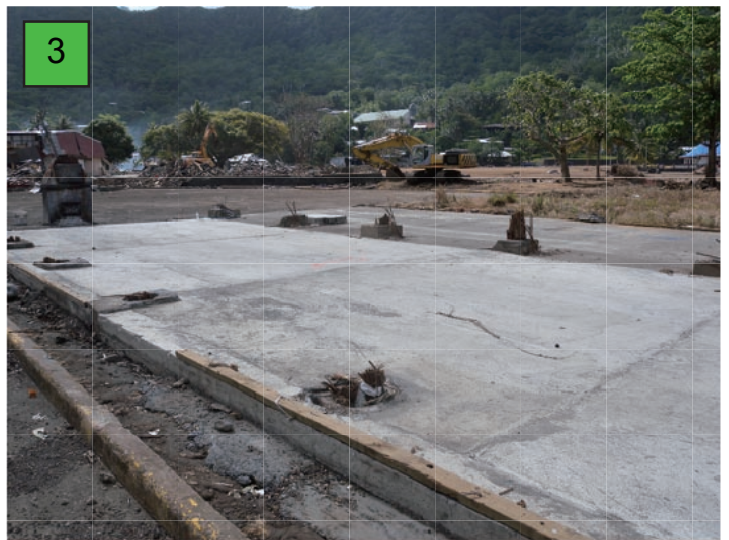
写真3: 津波によって流失した建物の跡。
