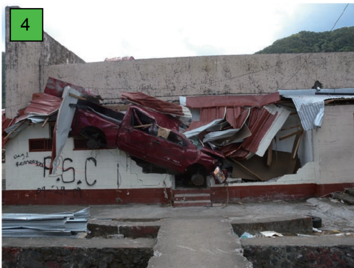
写真4: 津波で流された自動車と建物破壊の状況。
