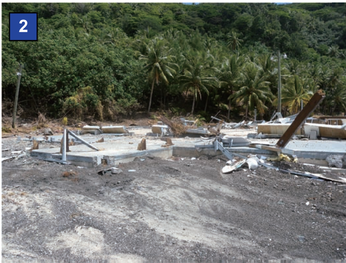
写真2: 津波によって流失した建物の跡(残っているのは基礎のみ)。
