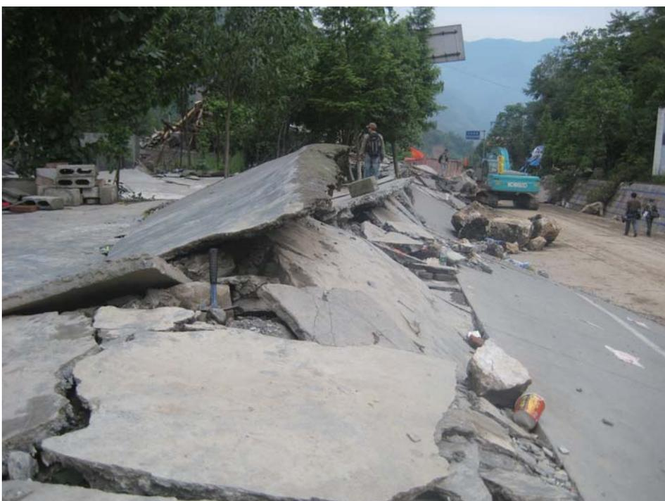
写真 汶川地震により生じた地表地震断層（北川県県庁所在地である北川町の南東約1km地点で撮影）。左（北西）側の木が生えた面と、右（南東）側の人物が立っている道路面は地震前には同じ高さでした。地震断層の食い違いによって左側と右側の地面には2.5mの段差が生じています。断層はこの道路とほぼ平行で、北東-南西方向に画面の奥に向かって伸び、北川町を横切っています。
