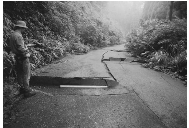
写真2 鎌倉山グリーンライン路面の雁行する圧縮変形
