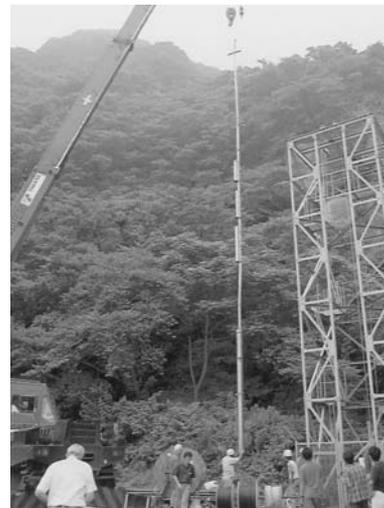
図2 鋸山にある海底地殻変動試験観測井(東京大学地震研究所)に設置直前の海底ボアホール用センサー部。三陸沖孔底に固定された広帯域地震計、歪計、傾斜計と同型のシステム。
