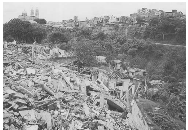
（上）ペレイラ市の被害（外壁・小屋組みに竹が用いられている）
