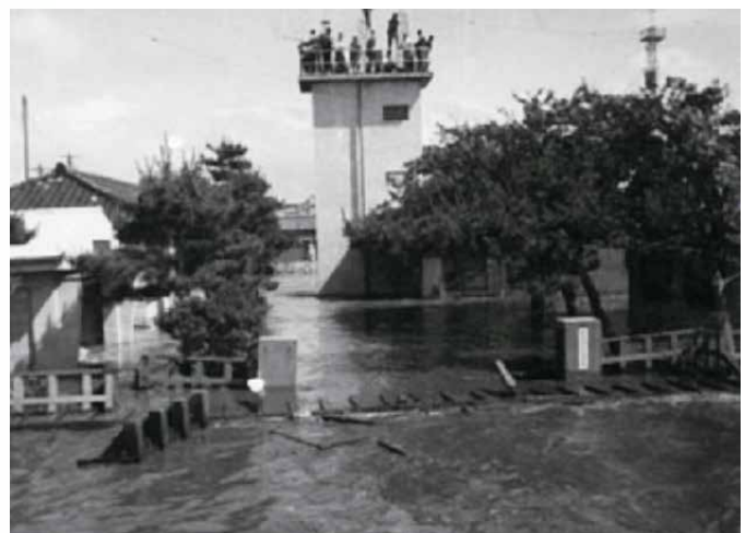
写真2 津波で浸水した新潟地方気象台。中央の塔の上に避難している人々が見える(新潟地方気象台ウェブサイトより引用)。
