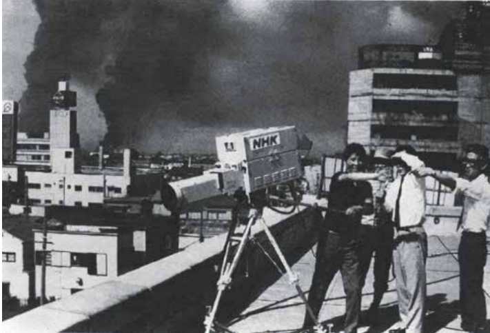
写真3 NHK新潟放送局はテレビカメラを屋上に上げて新潟市内の被害を中継した（NHK「20世紀放送史」より引用）。
