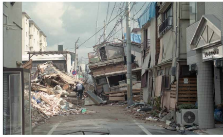
(b) JR 鷹取周辺の大被害の建物 (提供: 神戸市)
