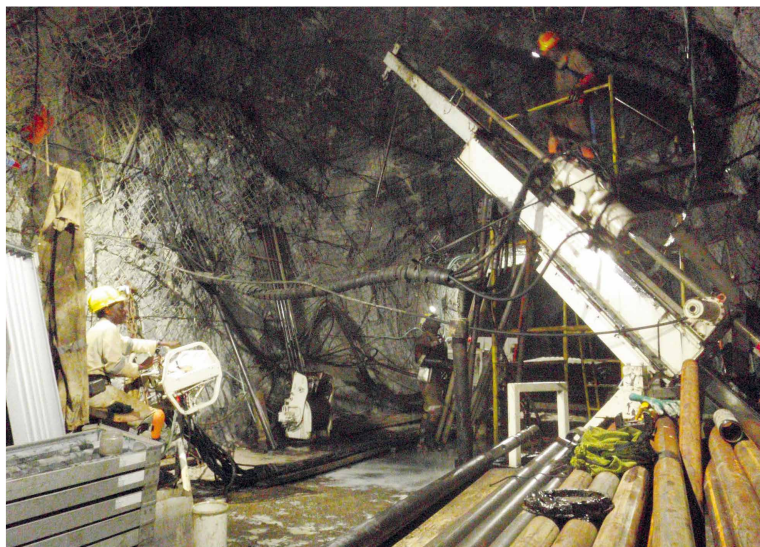
写真2 オークニー地区の鉱山の地下2.9kmに設置された掘削サイトでの作業の様子。計3本、総延長1.6kmの孔を掘削しました。
