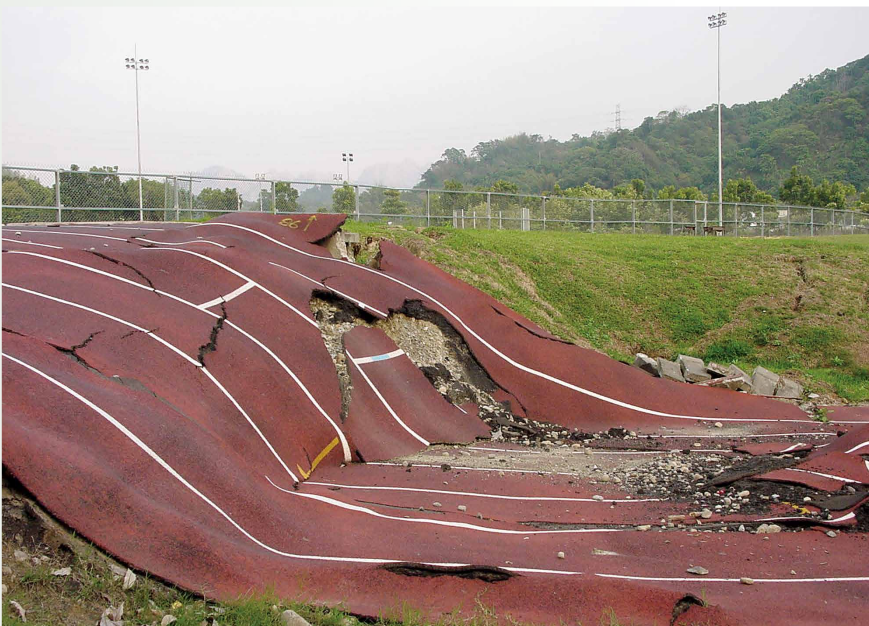
写真1 台中県光復国中学校のグラウンドの中を地震断層が通ったために上下に2.5mの段差が出来てしまいました。現在は、921地震教育園の一部として保存されています（2000年、筆者撮影）。
