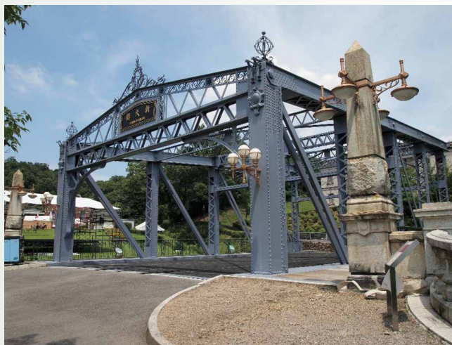
写真1 明治村に移築された「新大橋」
