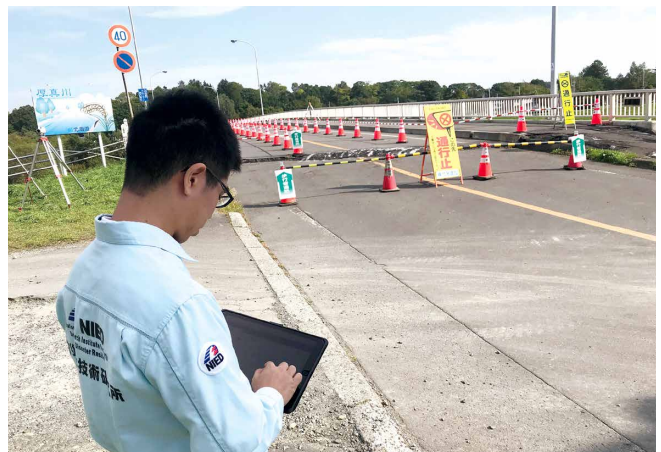
写真2 北海道胆振東部地震におけるフィールド調査の様子。SIP4Dで共有される情報をタブレットで確認しながら現場で活動。
