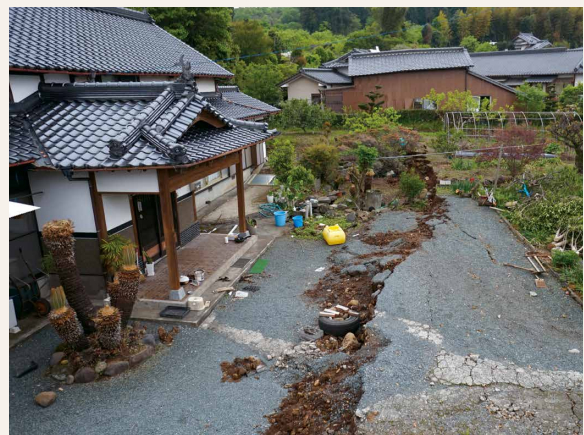
谷川地区の民家敷地内に露出した断層（中田高・広島大学名誉教授提供）
