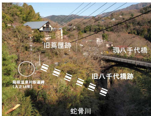
写真1 底倉の旧八千代橋あとの様子。現在の八千代橋は昭和42年の架橋。
