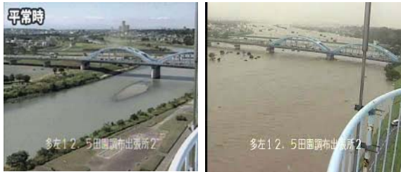
写真 7a 平時の多摩川 写真 7b 増水時の多摩川
