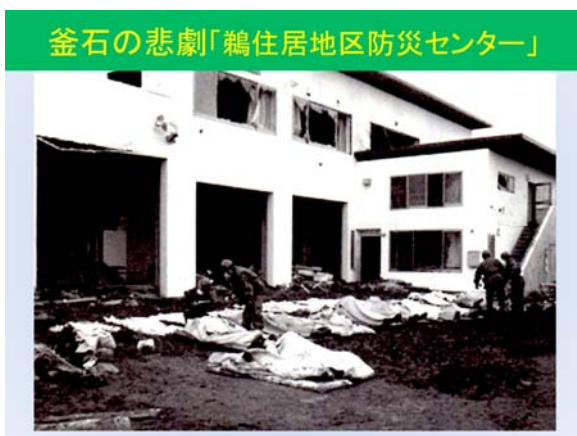
図7 直後の鵜住居防災センター
