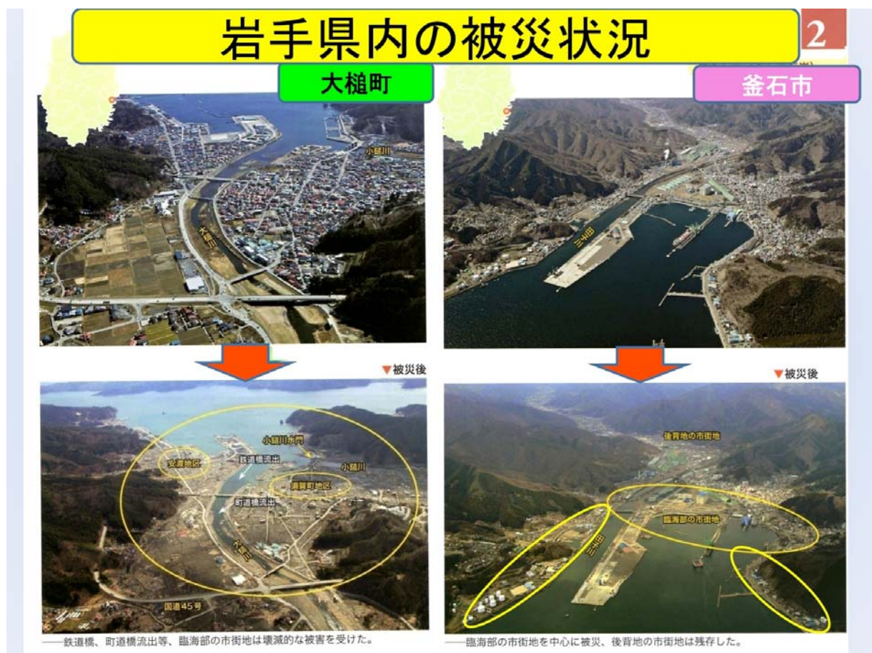
図1 大槌や釜石の被災状況
