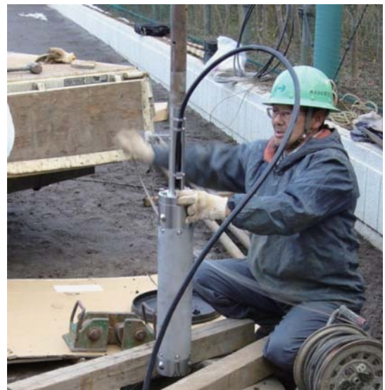
写真1 観測井戸に地震計を設置しているところ。
