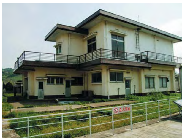
写真3 メモリアルハウス。断層はわずかに建物を避けて走っていた。
