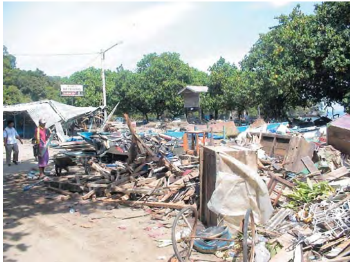
写真1 全壊した木造家屋 (Pangandaran 郡)
