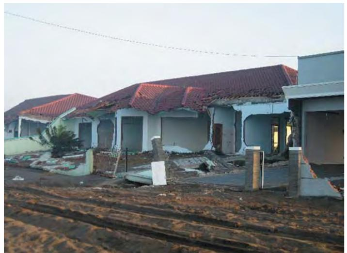
写真2 損傷した石造建築 (Pangandaran 郡)
