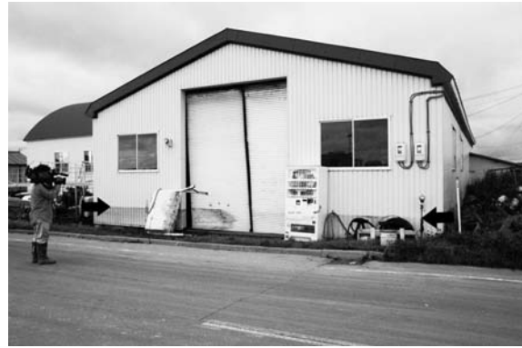
左写真：津波による漂着物（津波堆積物）の海面からの高さを測る様子。堆積物の左側の草が津波で倒れている。右写真：津波の直線的な跡が建物の白い外壁に残っている（矢印の位置）。（共に、北海道大学西村裕一氏撮影）詳しくは、p.3の記事「2003年十勝沖地震で発生した津波」をご覧ください。
