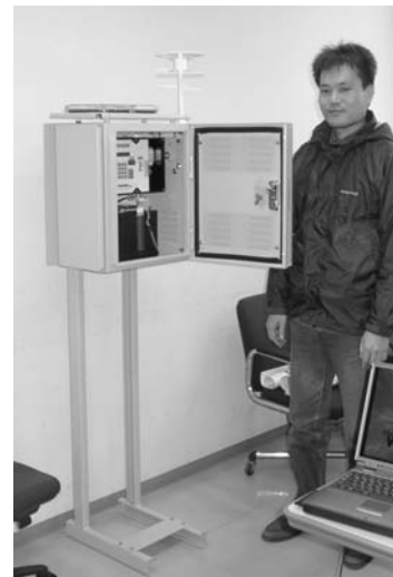
写真 新しく開発した微気圧計システム。気圧センサー、データロガー、バッテリーがひとつの箱に収められています。
