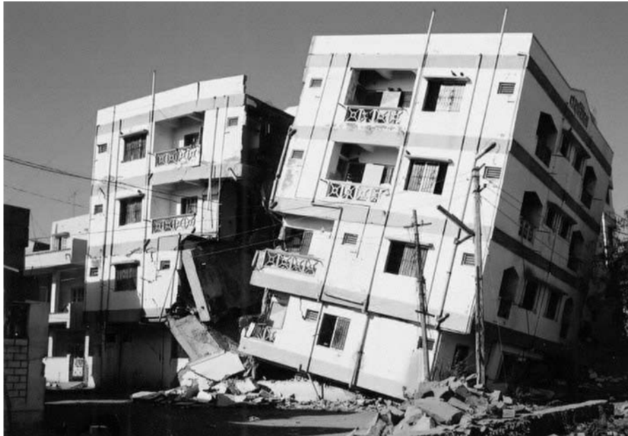
真ん中から剥離した5階建マンション（ブージ市、まちづくり計画研究所提供）
