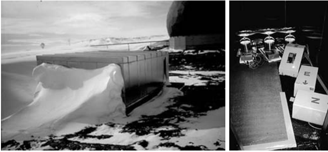
写真2 左：新地震計室の外観。 右：短周期・広帯域地震計の設置風景。
