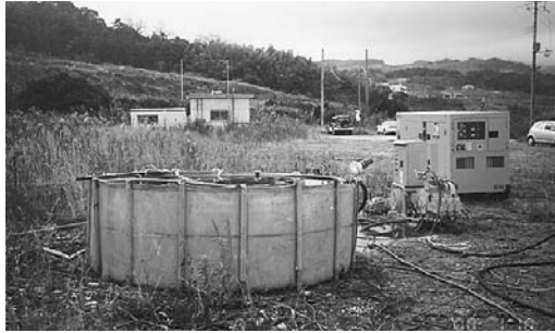
写真1 1,700m孔口横に設置された注水用タンク、ポンプ、および発電機（手前中央から右へ）、遠方の白っぽい建物は野島断層観測室（京都大学防災研究所）
