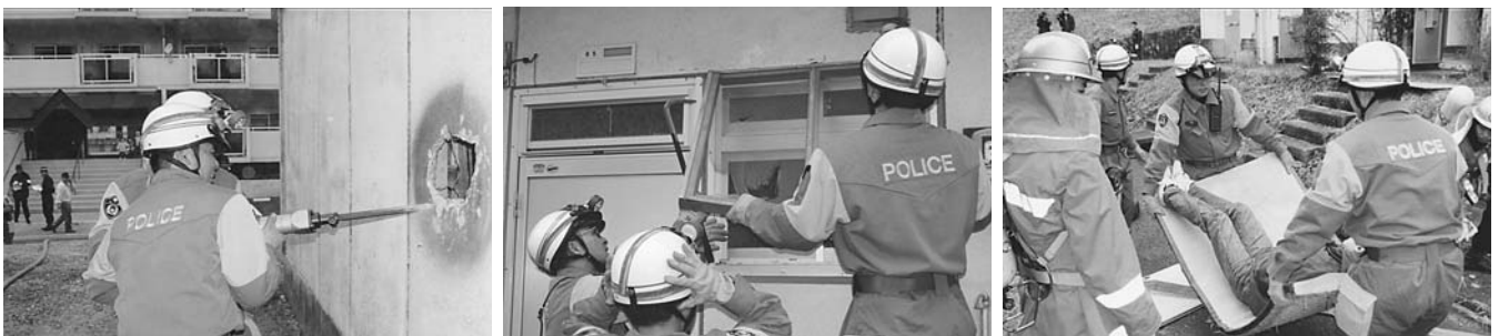
1997年1月14日に、全くの抜き打ちでおこなわれた兵庫県の防災訓練。姫路市内の老朽化した県営住宅を実際に壊し、警察・消防・自衛隊が、被災者に扮したボランティアの救出訓練をおこなった。
