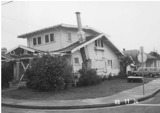
(左) 1989年10月18日(日本時間)に起こったロブリータ地震で被害を受け、余震による倒壊のおそれのある民家(米国カリフォルニア州ワトソンビル市)。(右)被害を受けた建物に表示された被災度判定結果の一例。この表示は立入禁止を示します。窪田 将氏((財)地震予知総合研究振興会)撮影・提供。
