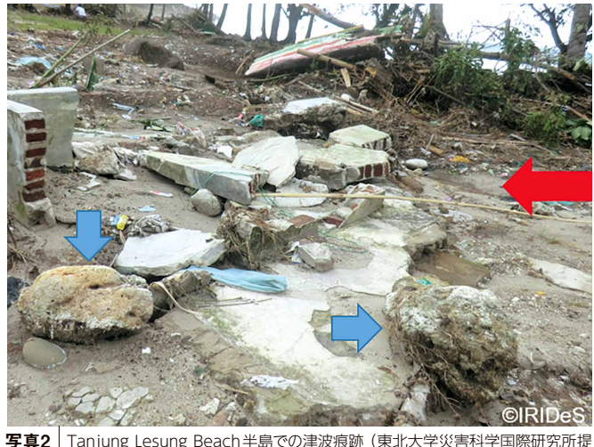
写真2 Tanjung Lesung Beach半島での津波痕跡（東北大学災害科学国際研究所提供）。沿岸からの強い波力（赤い矢印）により破壊された住宅と周辺に移動した珊瑚岩（青い矢印）。
